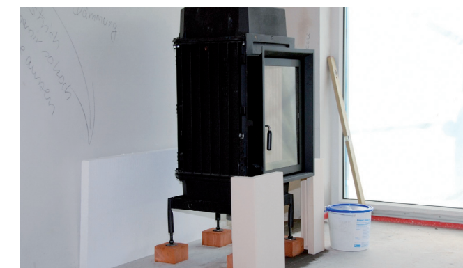
Aufstellung des Kachelofen-Heizeinsatzes
